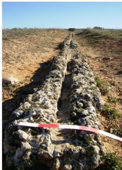
Tramo del canal ( specus ) que transportaba el agua desde la fuente de captación de aguas, en Saelices, hasta la ciudad de Segóbriga.
